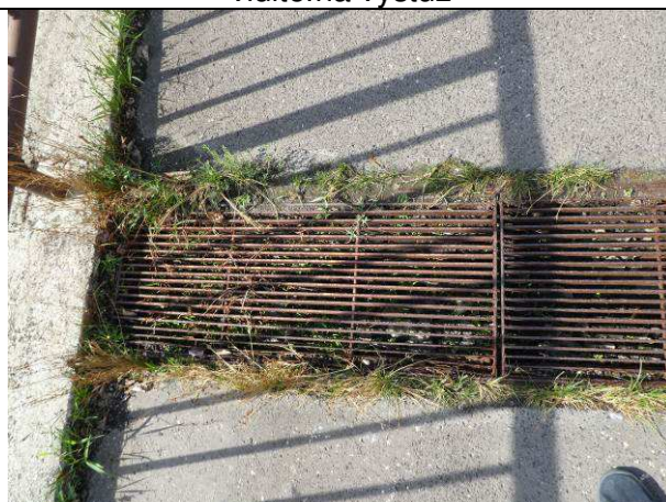
Obr. 22 – zanesený odv. žľab rampy + nežiadúca vegetácia v jeho okolí
