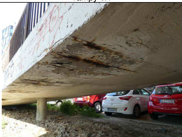
Obr.15 – poruchy na spodnom povrchu NK rampy č.2
