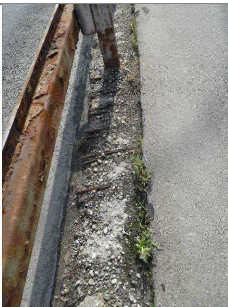
Obr. 19 – rozpadnutá rímsa + viditeľná výstuž
