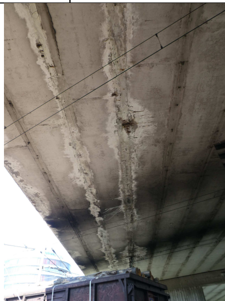
Obr. 4 – znečistený povrch NK v piatom poli
