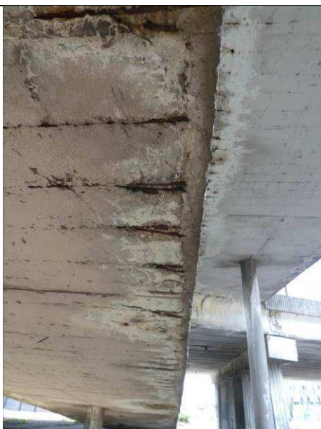
Obr. 13 - poruchy na spodnom povrchu NK rampy č.1
