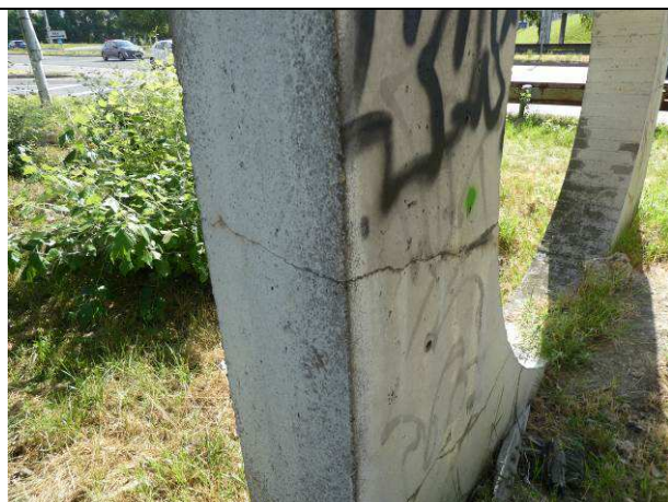
Obr.16 – trhliny na pilieroch rampy č.2
