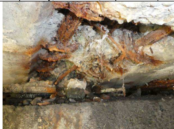
Obr.10 – viditeľná a porušená oblasť dobetonávky nosníkov nad oporou č.9
