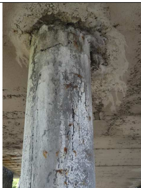
Obr. 14 - trhliny a zatekanie na pilier rampy č.1
