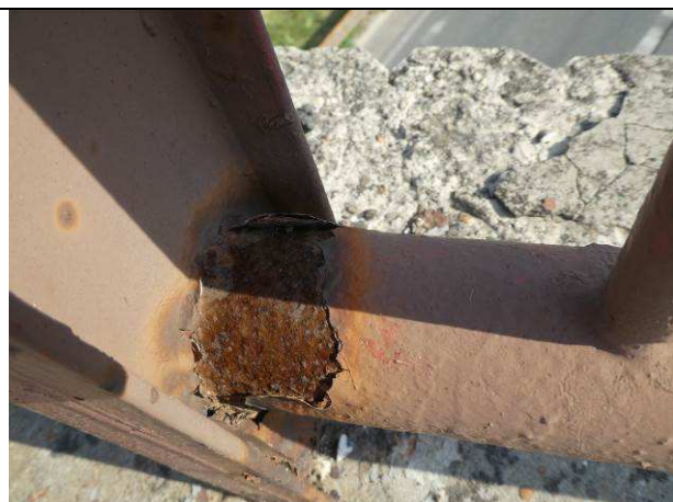
Obr. 23 – poškodená PKO zábradlia
