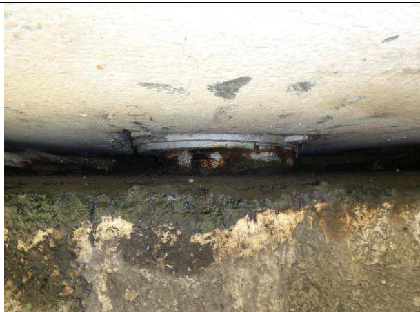
Obr. 9 – korózia ložiska + strata funkčnosti
