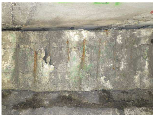
Obr. 11 – nedostatočné krytie výstuže úložného prahu
