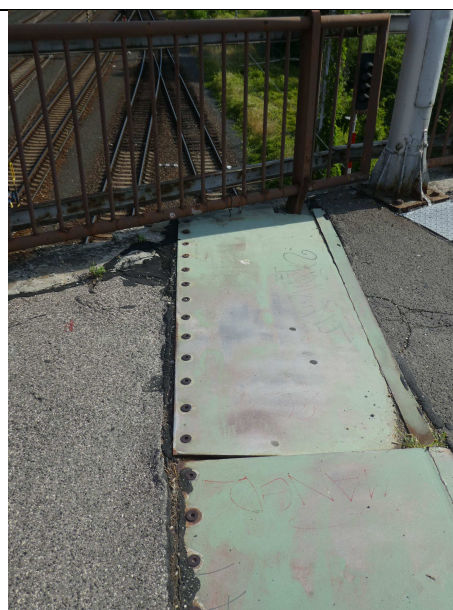
Obr. 28 – Poškodenie krycieho plechu nad MZ v priestore chodníka na prechodovej podpere
