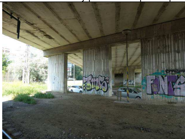
Obr. 6 – znečistený povrch pilierov (grafity)
