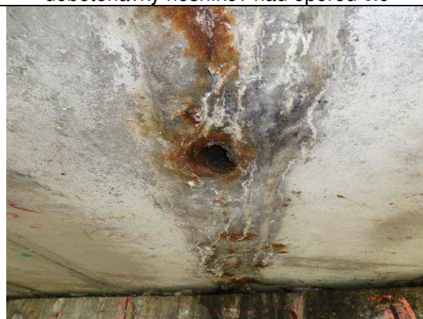
Obr. 12 -vyústenie odvodňovača na spodnom povrchu NK
