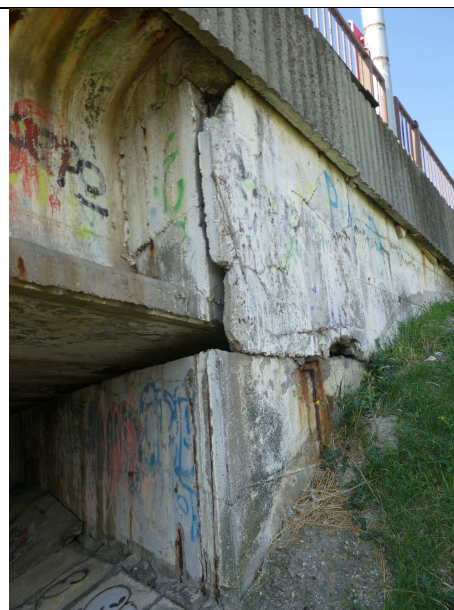
Obr. 8 – poruchy opory č. 9 (zatekanie, trhliny, praskliny, znečistenie, rozpad betónu)
