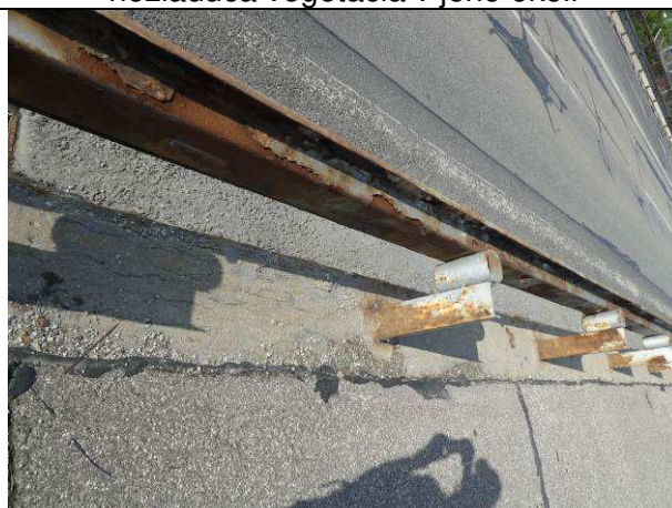
Obr. 24 – poškodená PKO zvodidla
