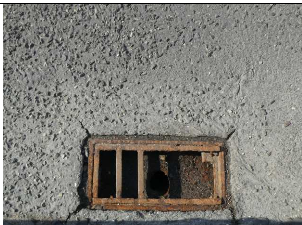
Obr. 21 – poškodený odvodňovač
